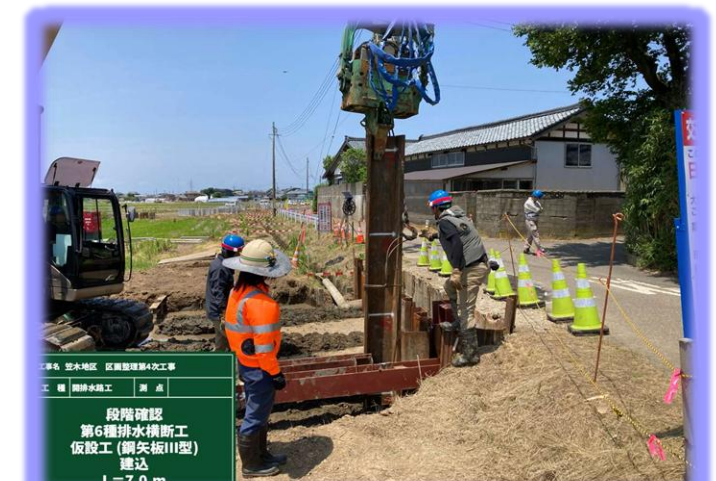
第6種排水横断工 鋼矢板打込
